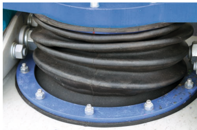
Die Durchführung von Rührwerken aber auch Fermenterabdichtungen und Gasleitungen sind häufig von Lecks betroffen.
